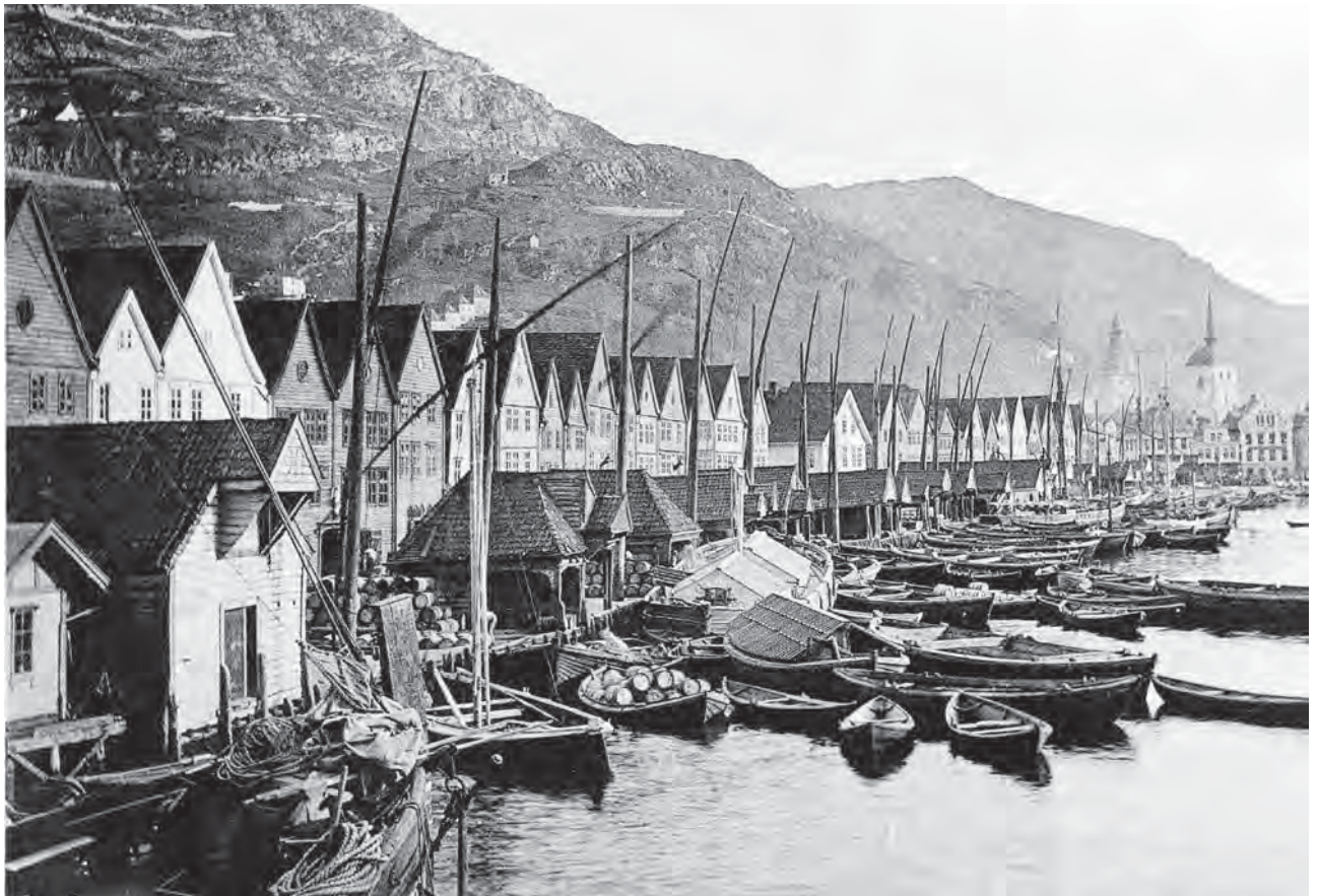
Figur 2 Bryggen i Bergen i 1889. Fotoet viser den tradisjonelle strukturen med bryggerekken og vippebom og skur på kaikanten. Foto hentet fra http://www.arkivverket.no
