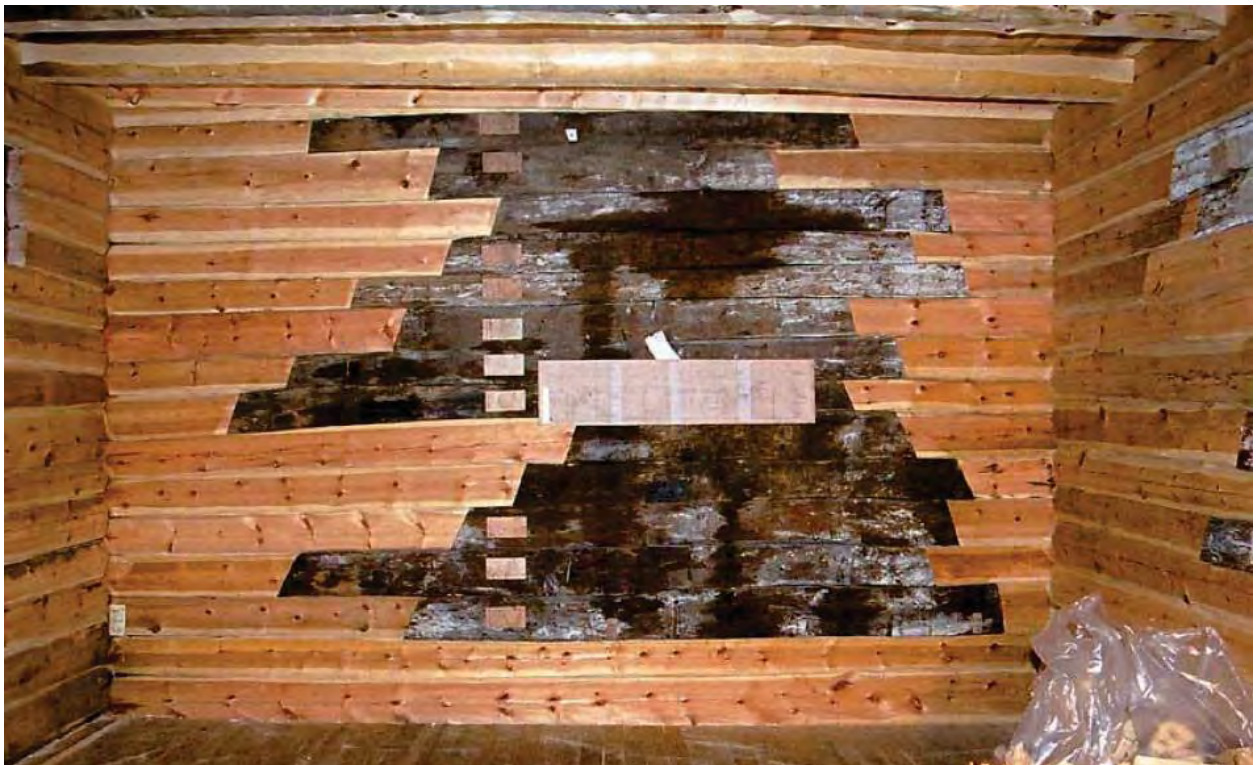
Figur 3 Bygning 4e, østvegg etter istandsetting. Foto Stiftelsen Bryggen v. E. Jensen 2004.
