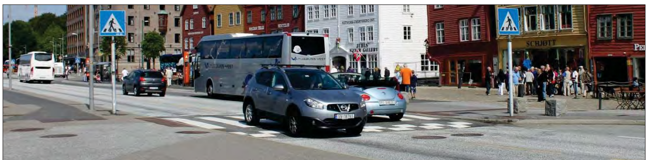
Lappet asfaltareal og betongkantstein på kjørearealet.
