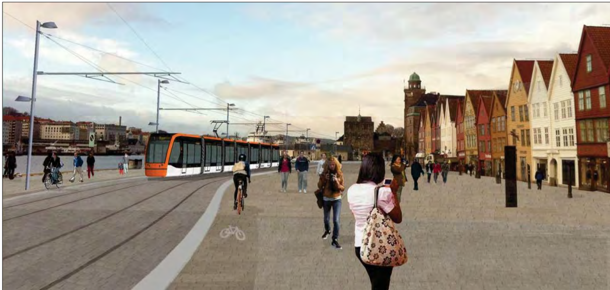
Situasjon med Bybane over Bryggen, med ensidige master og kjøreledningssystem.
